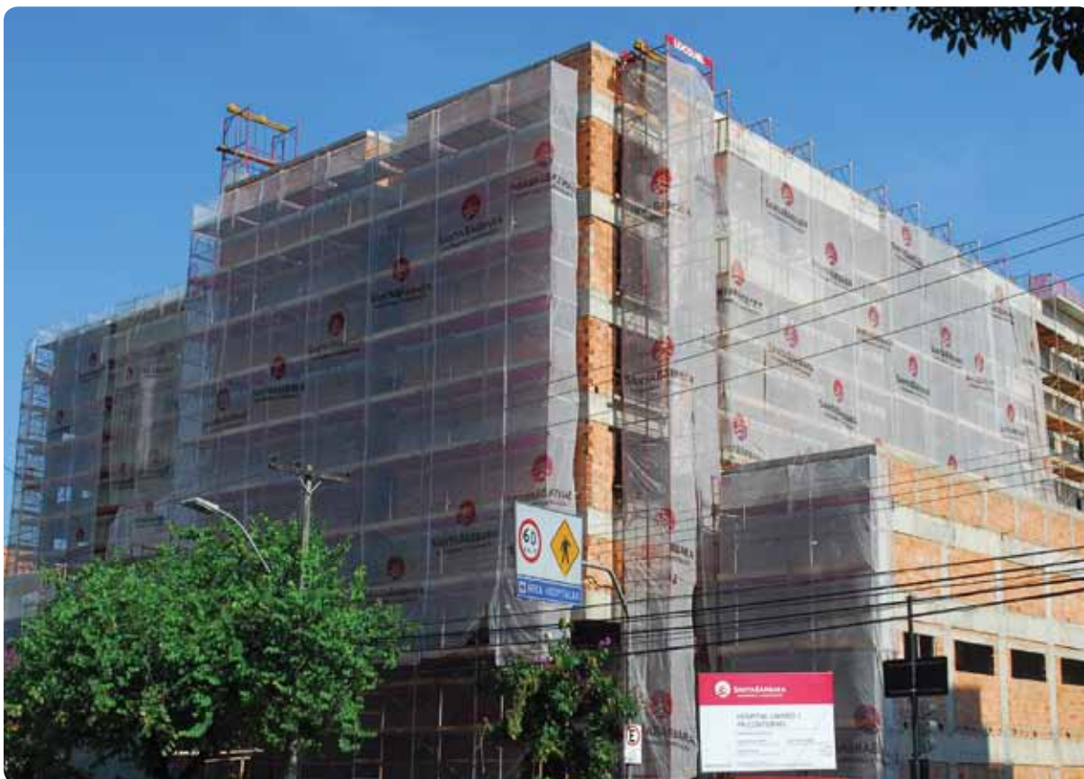
Com suas obras adiantadas, o Hospital Unimed será referência para urgências e emergências de alta complexidade
